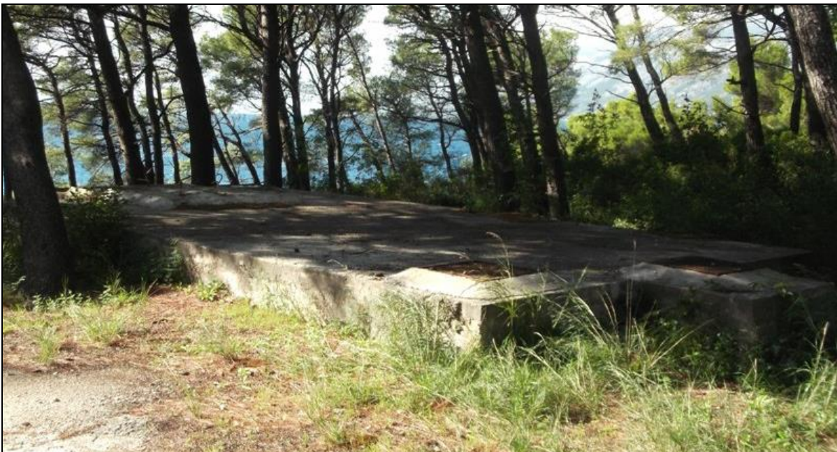
Fotografija A.2-3 Dozažni bazen u Brelima odakle otpadna voda gravitacijski otječe u podmorski ispušt
