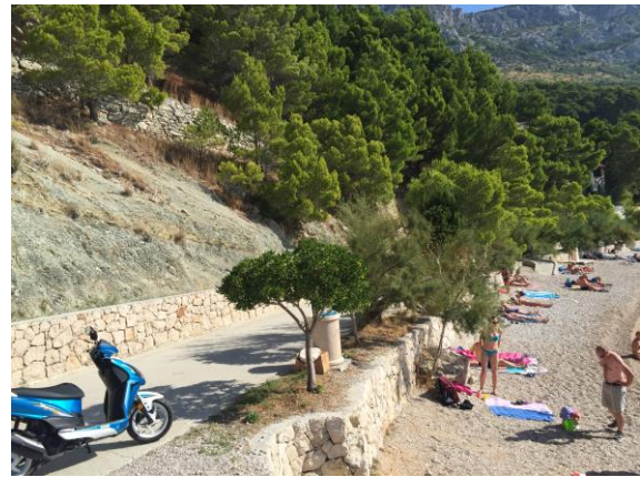
Fotografija A.2-2 Glavni obalni kolektor iznad šetnice - na vrhu pokosa zaštićen kamenim zidom (gore lijevo na slici)
